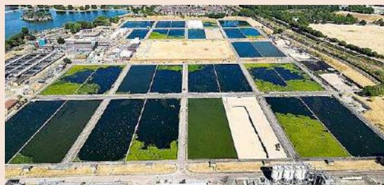
Planta de tratamiento de agua de Coppermills, cuyos trabajos ha comenzado Acciona.
