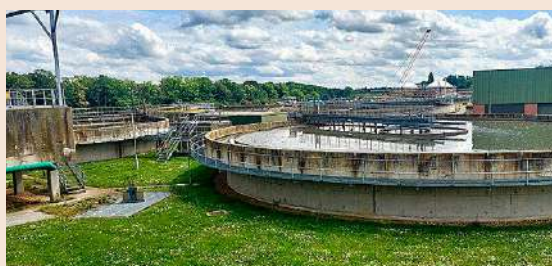
Ferrovial ha comenzado recientemente los trabajos de la depuradora de Slough.
